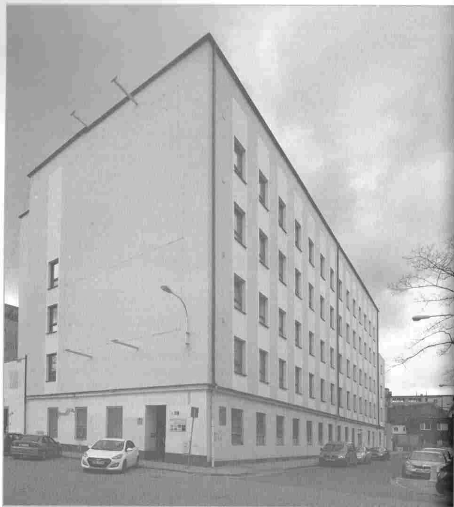
DNEŠNÍ STAV BUDOVY NA ČECHYŠKÉ UL. Č. 14, V NÍŽ BYLA TOVÁRNA MOSES LÖW-BEER (FOTO M. ZAVADIL)
